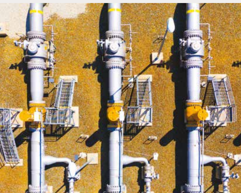
MONITORAGGIO STRTTURALE DEGLI GASDOTTI
